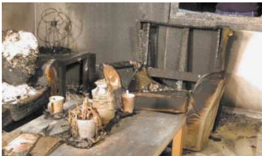
Brandskador med och utan boendesprinkler.
